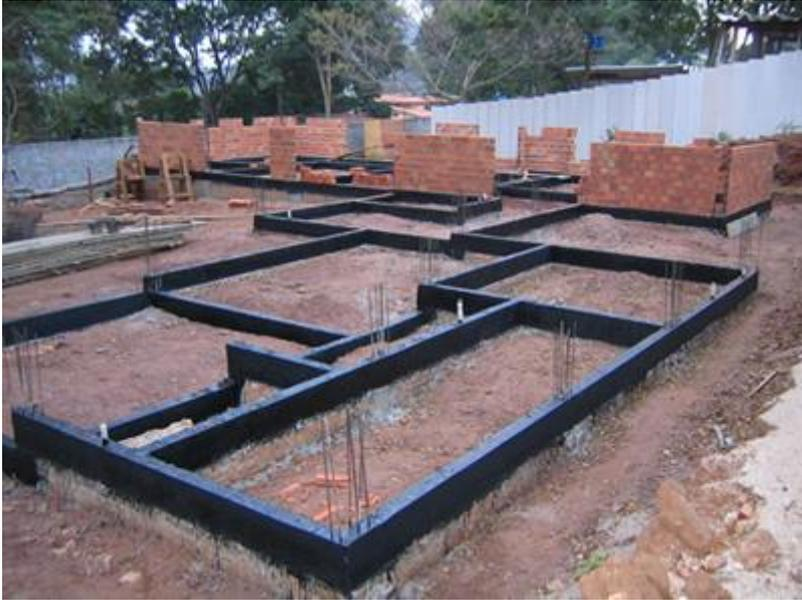
**Figura 7: Viga impermeabilizada.**
