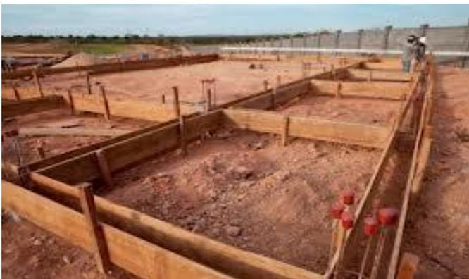
**Figura 6: Montagem das formas para concretagem da viga.**
