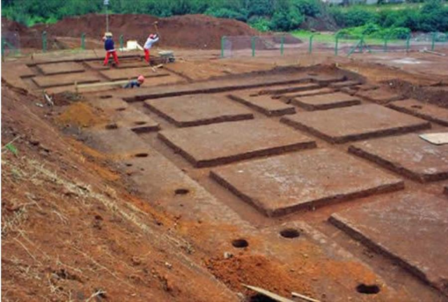
**Figura 5: Abertura de valas para a viga baldrame.**
