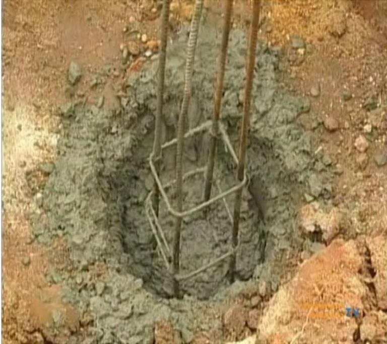
**Figura 9: Broca concretada junto com a armação.**
