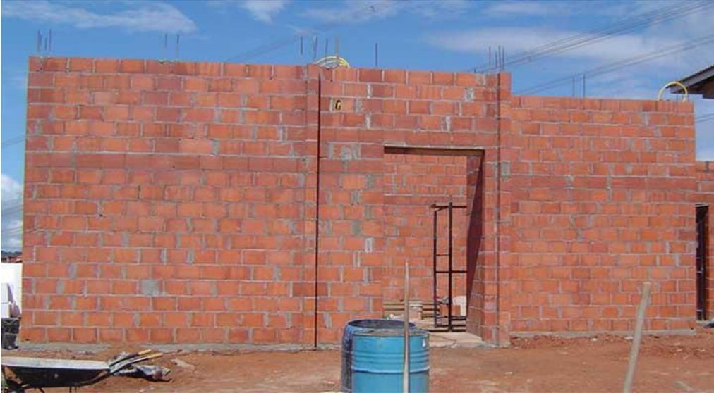
**Figura 10: Vedação em alvenaria convencional com blocos cerâmicos.**
