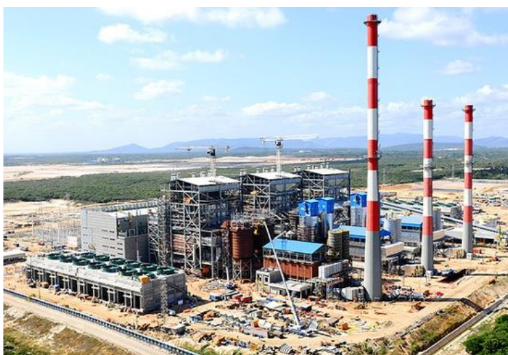
Figura 2- Usina Termelétrica de Pecém II.
