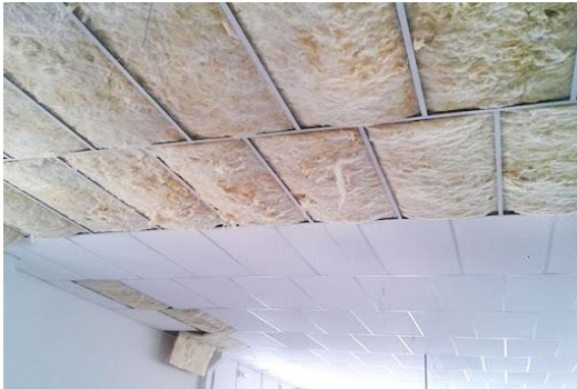
Figura 4: Isolamento térmico e acústico usado na construção e caracterizado por sua alta resistência térmica
