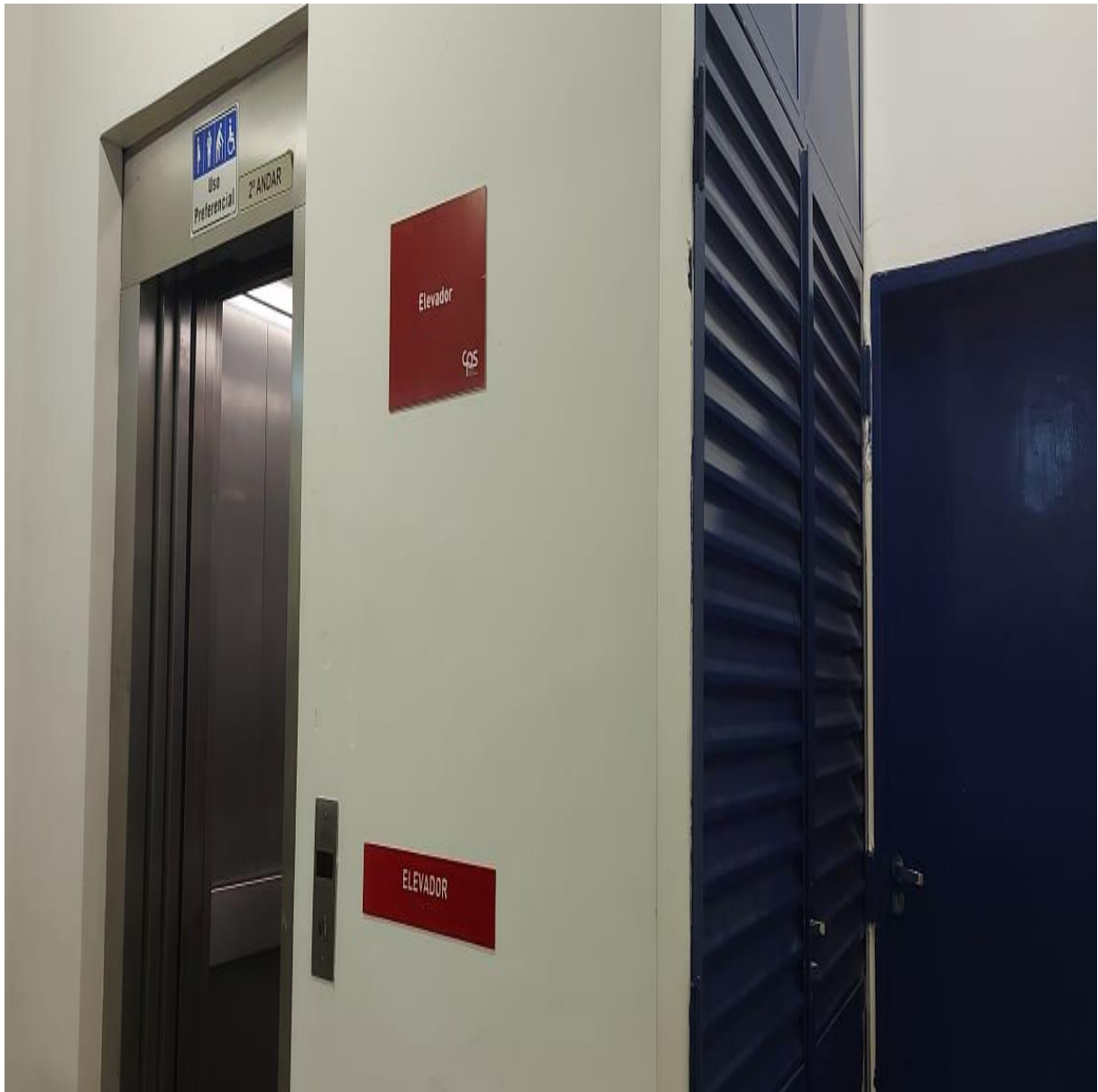
Figura 11: quadro de energia
