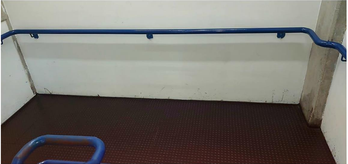
Figura 7: escada de emergência
