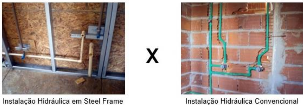
Figura 13 – Instalação hidráulica em Steel Frame e Convencional
