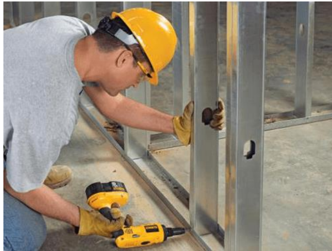
Figura 19 – Fixação por parafusos, dispensando o uso de concreto ou argamassa.
