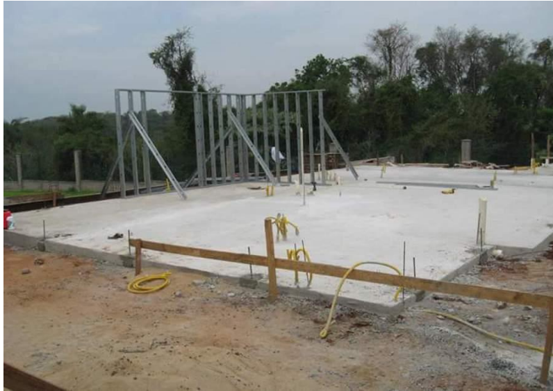
Fonte: Habitissimo – Radier: residência em steel frame.
