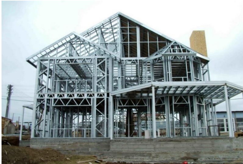
Figura 1 – Estrutura Steel Frame
