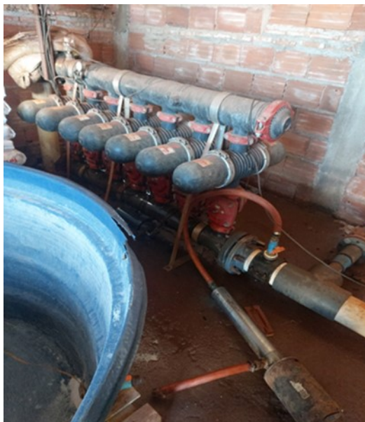
Figura 17: Reservatório de água e motor responsável por captar a água do mesmo.
