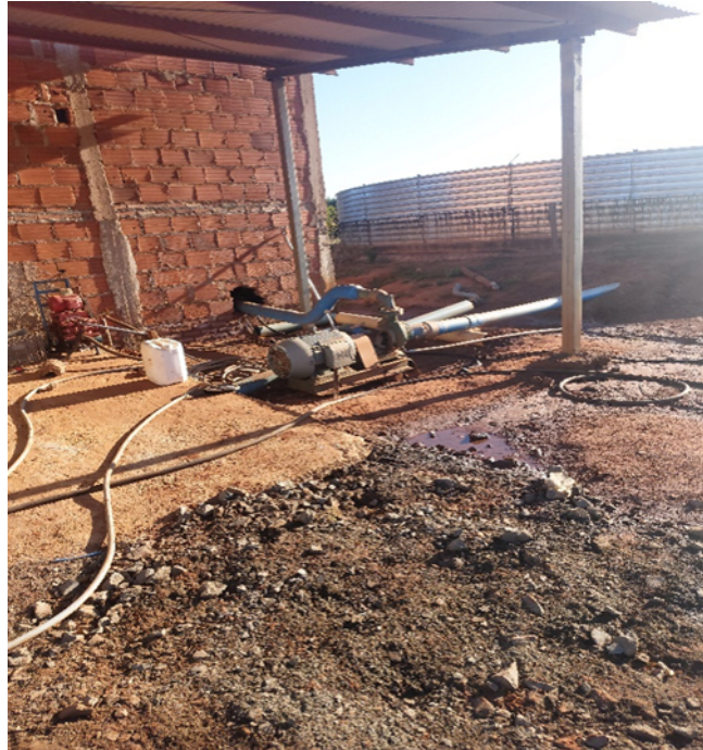
Figura 18: Motores responsáveis pela mistura da água com a solução e a caixa d'água onde a mesma é depositada.
