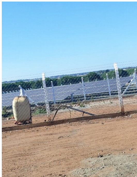
Figura 16: Painéis de energia fotovoltaica
