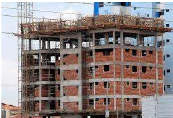
Figura 5 - Edificação em Construção
