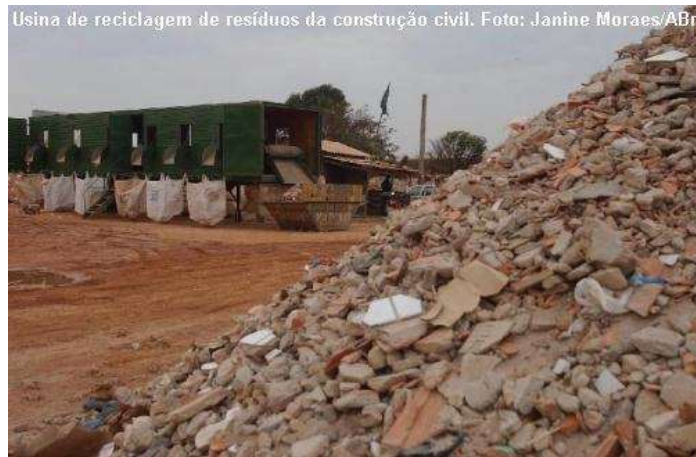
Figura 3 - Resíduos de Demolições da Construção Civil
