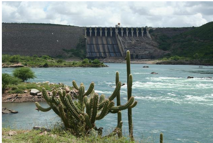
Figura 22 - Foto retirada de uma usina hidrelétrica situada no nordeste do Brasil
