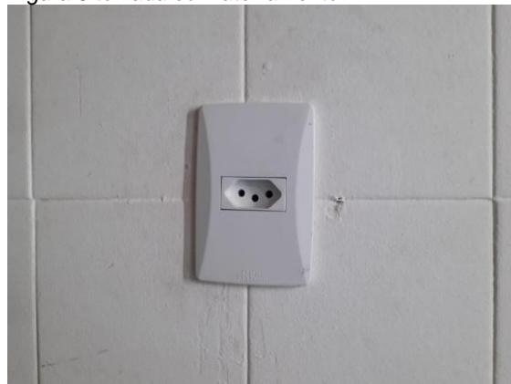
Figura 5 tomada com aterramento.
