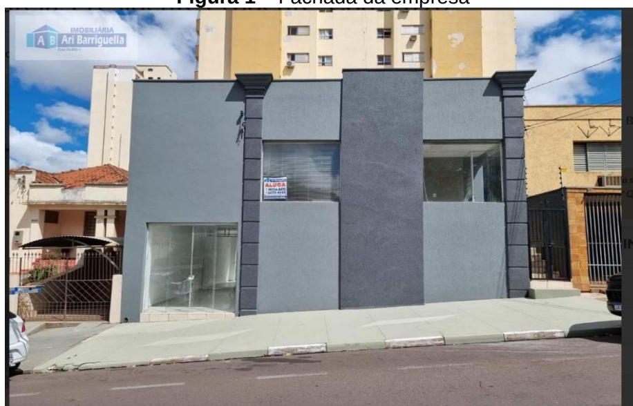
Figura 1 – Fachada da empresa
