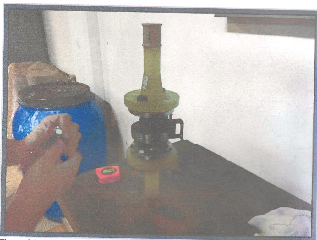
Figura 34 - Fixação dos parafusos dos flanges na válvula
