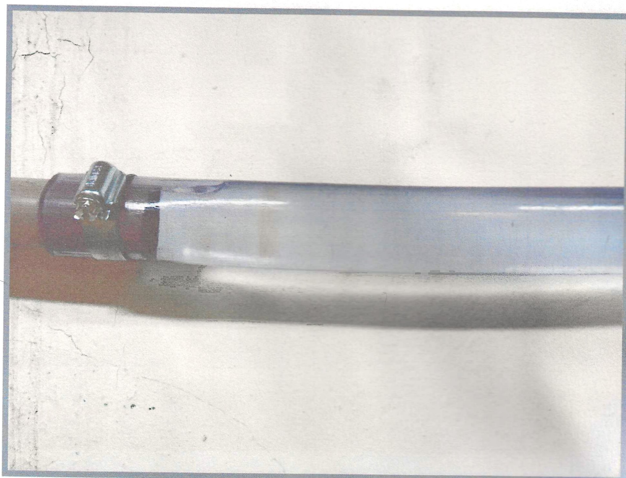
Figura 44 - Mangueira cristal instalada
