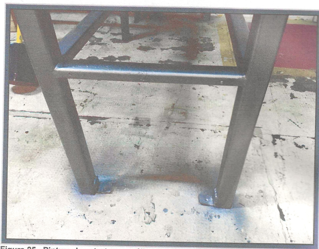
Figura 25 - Pintura da estrutura metálica das bancadas
