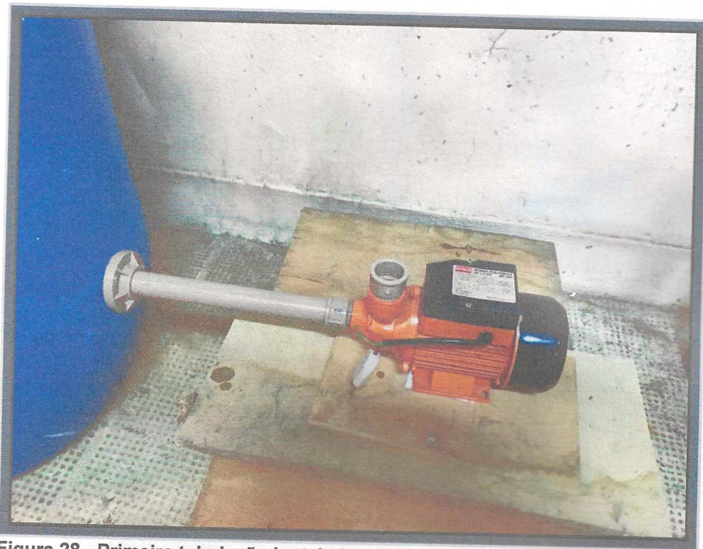
Figura 28 - Primeira tubulação instalada, nipes instalados
