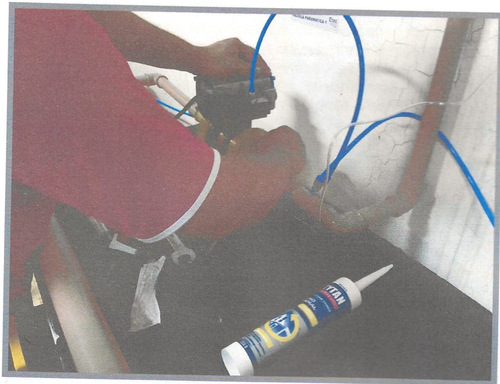
Figura 56 - Manutenção de válvula com vazamento
