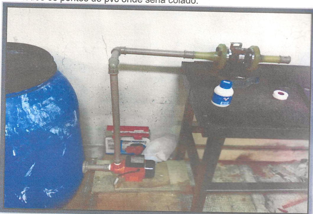
Figura 32 - Primeira válvula já instalada
