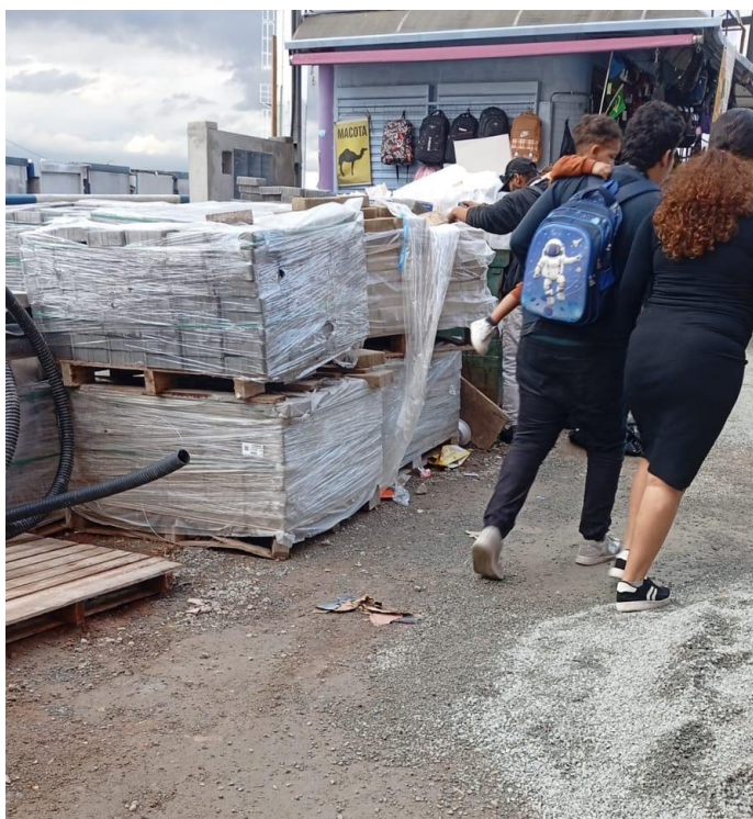
Figura 2 – Redução da faixa livre de circulação durante as obras do Novo Calçadão.
