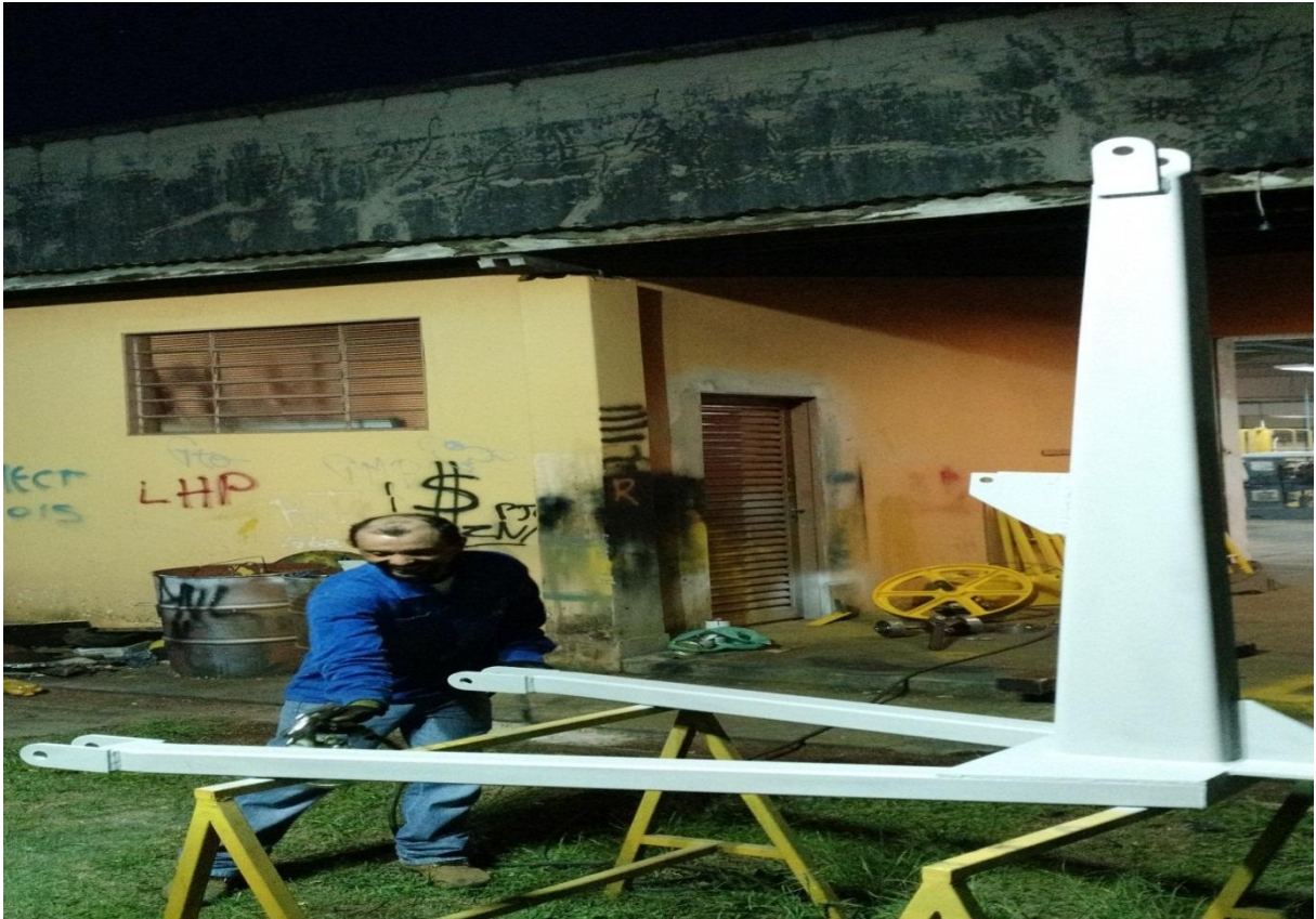
Figura 20- Pintura da Estrutura
