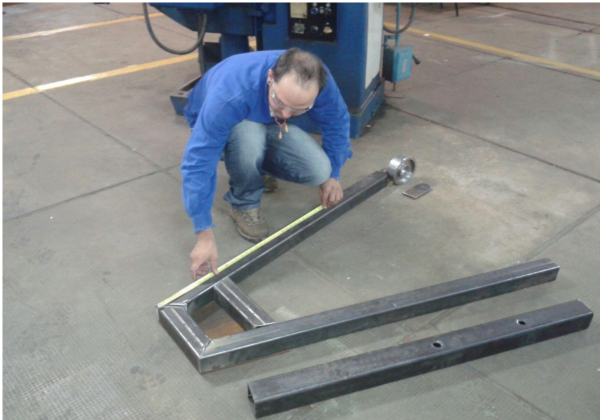
Figura 11 – Traçagem e montagem da parte inferior
