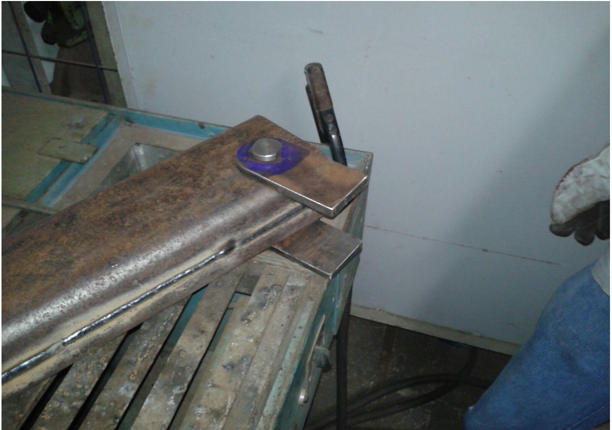
Figura 8 – Montagem da viga superior
