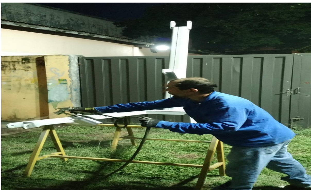
Figura 19 – Pintura da Estrutura
