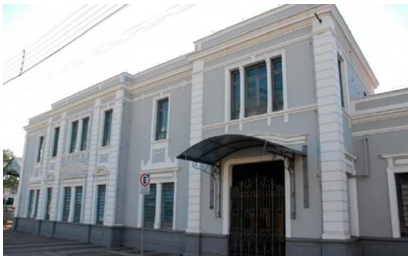
Figura 10: Patrimônio Histórico – Estação Ferroviária - Limeira-SP
