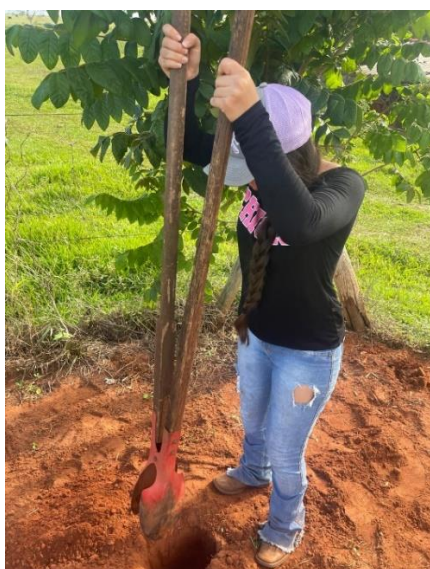
Figura 5: Escavação para a estrutura do sombrite
