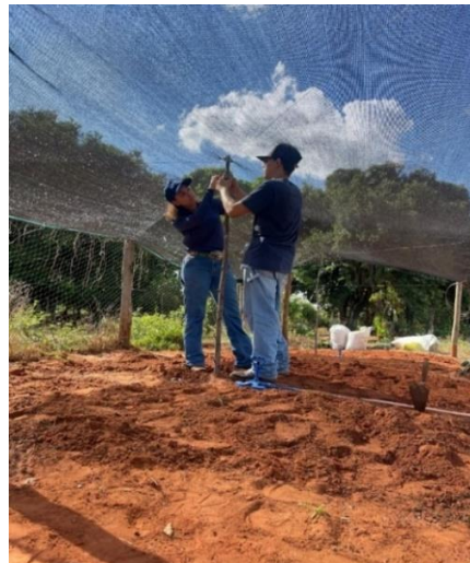
Figura 8: Instalação do sombrite
