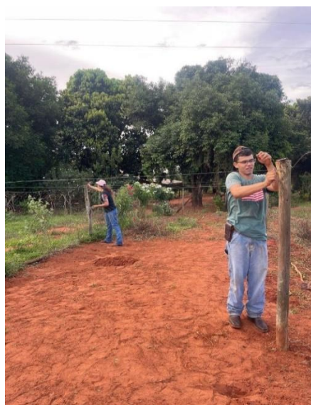
Figura 6: Montagem da estrutura do sombrite
