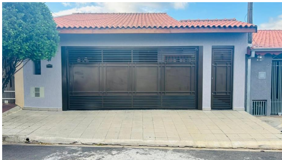
Imagem 10 – Imagem retirada no local de vistoria.
