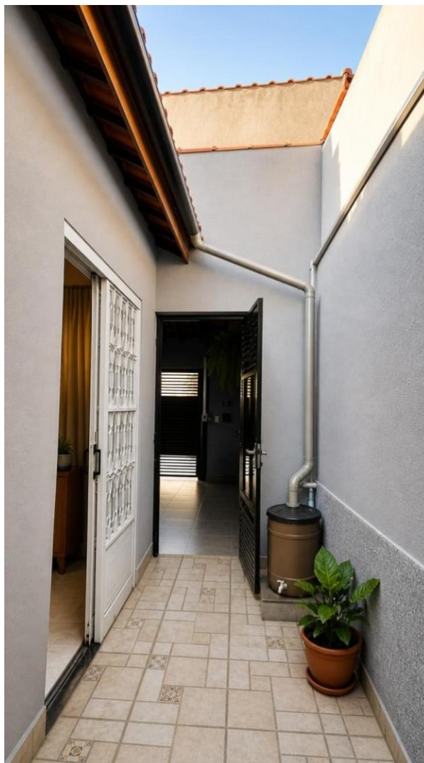
Imagem 13 – Imagem ilustrativa do corredor com Sistema de Captação de Água da chuva.
