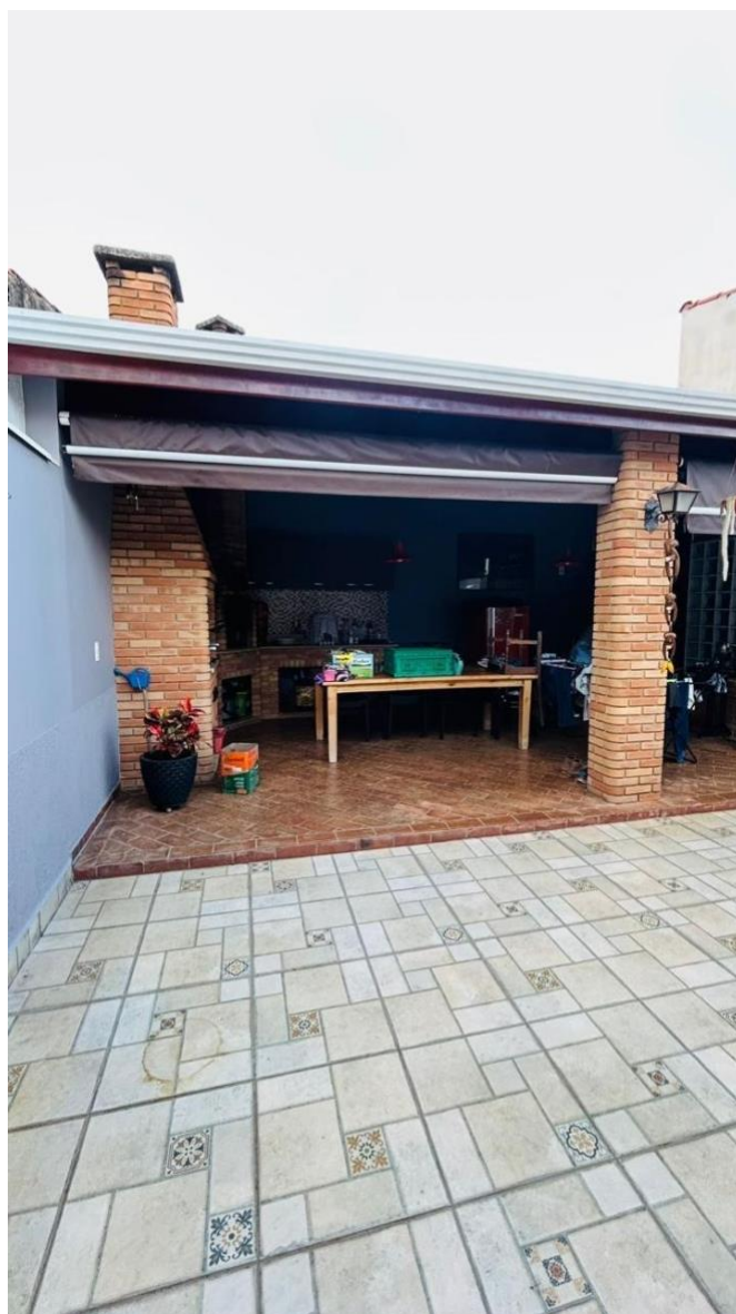
Imagem 14 – Imagem retirada no local de vistoria
