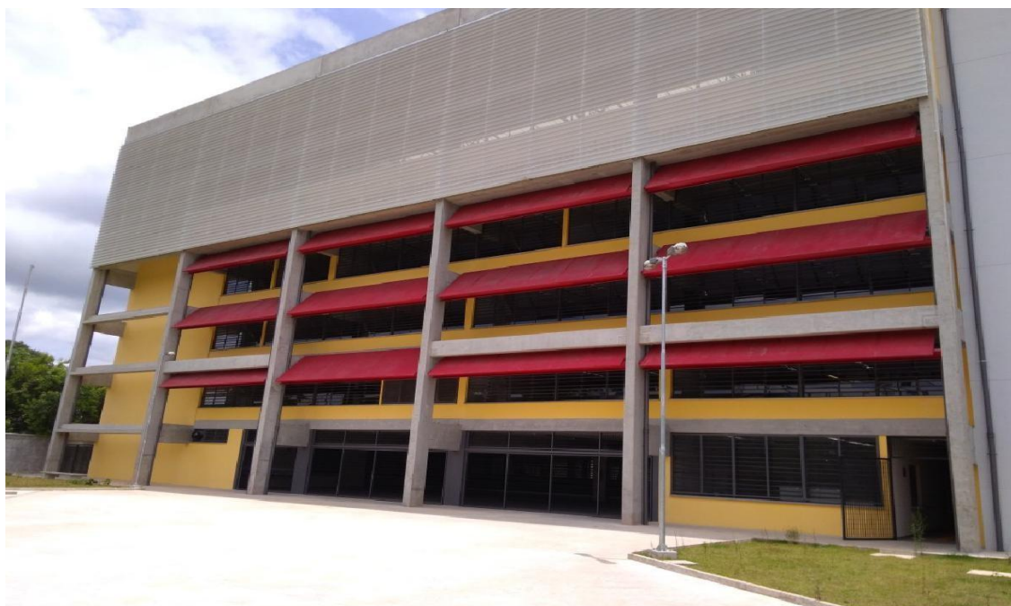
Figura 9 – Fachada do Prédio Principal da Etec de Taboão da Serra.
