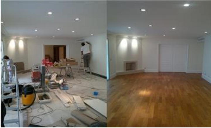
Figura 3: Antes e depois de uma obra 2.
