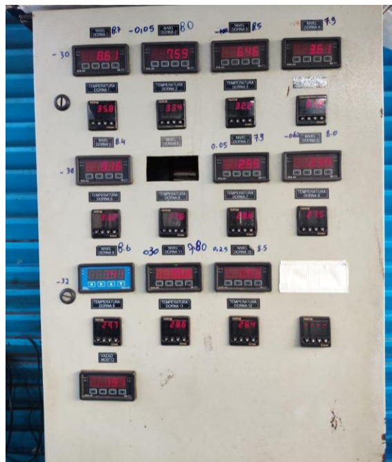
Figura 11 - Onde fica o nível e temperatura de cada dornas
