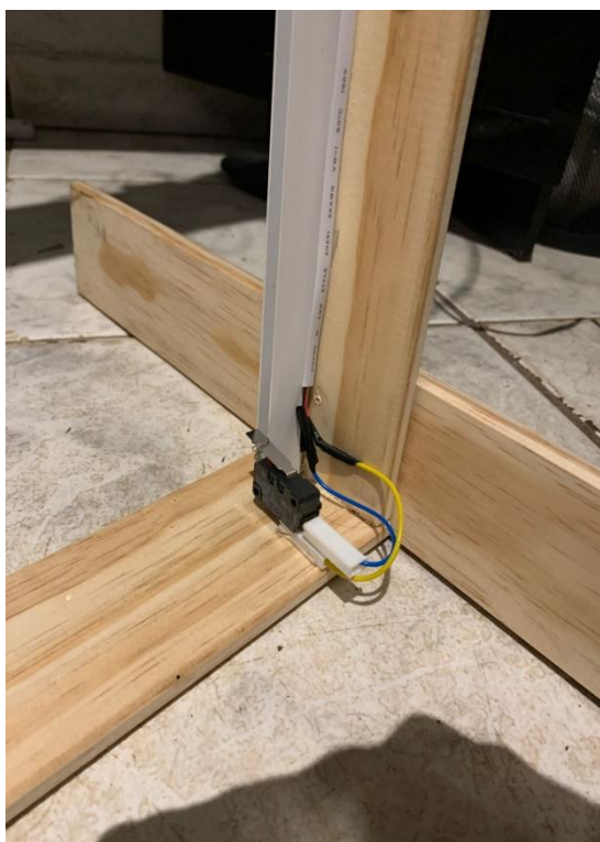
Fig. 5- Sensor de presença infravermelho instalado na base da moldura do protótipo como medida de segurança.
