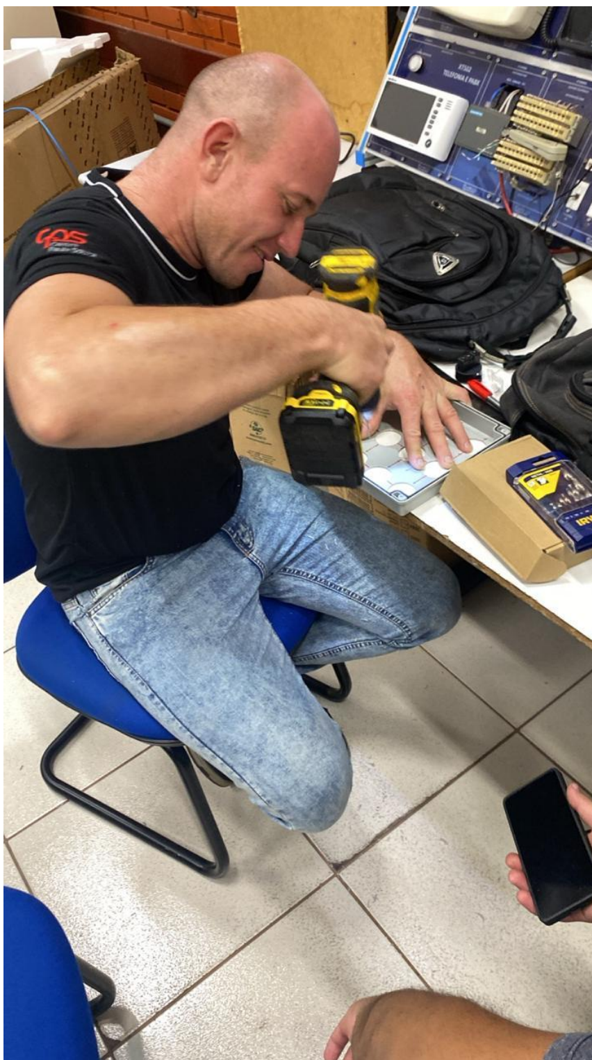
Figura 8: Processo de furação da caixa elétrica para os parafusos de fixação das tomadas.
