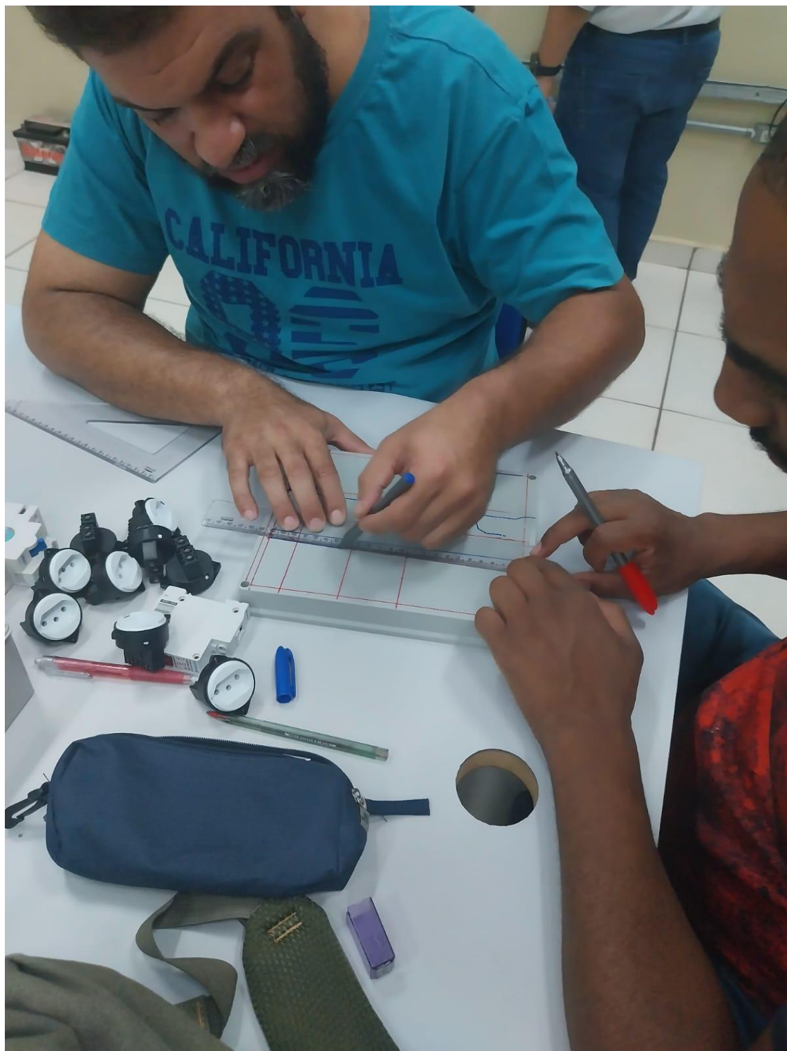
Figura 7: Verificação métrica do espaçamento e alinhamento das tomadas de automação no painel de comando, garantindo o acesso seguro e ergonômico para os periféricos.
