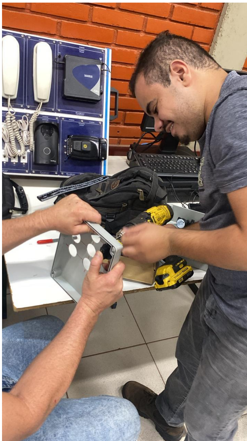
Figura 9: Etapa de fixação das tomadas
