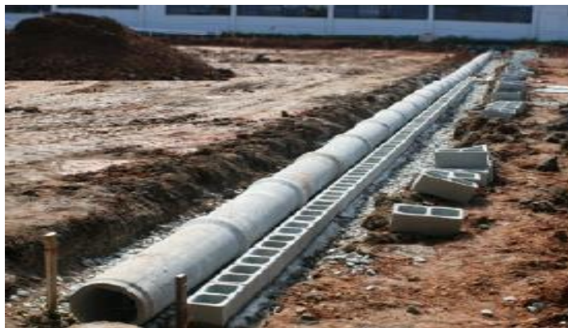
Figura 21: instalação da rede de drenagem (Fonte: Acervo Afonso Virgiliis)
