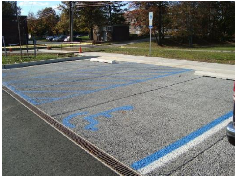
Figura 24: obra concluída (Fonte: Acervo ABCP)
