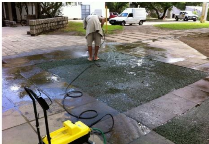
Figura 25: Lavagem sob pressão (Fonte: Lamb (2014))
