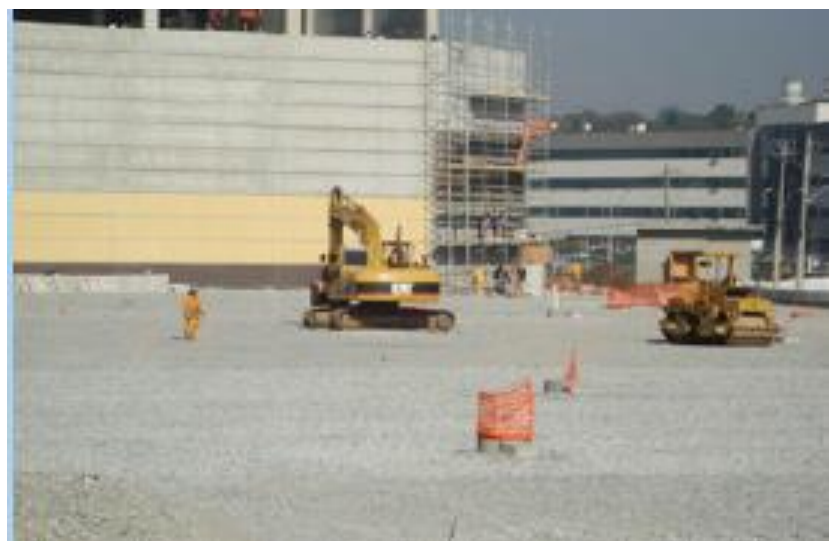
Figura 22: Espalhamento das camadas de brita (Fonte: Acervo ABCP)
