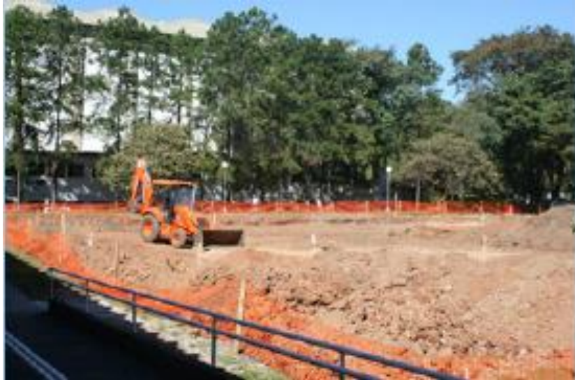
Figura 18: limpeza do terreno (Fonte: Acervo Afonso Virgiliis)
