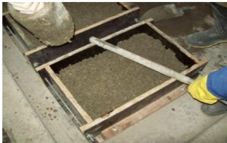
Figura 9: vibração com vibrador tipo agulha (Fonte: Hölztz 2011).
