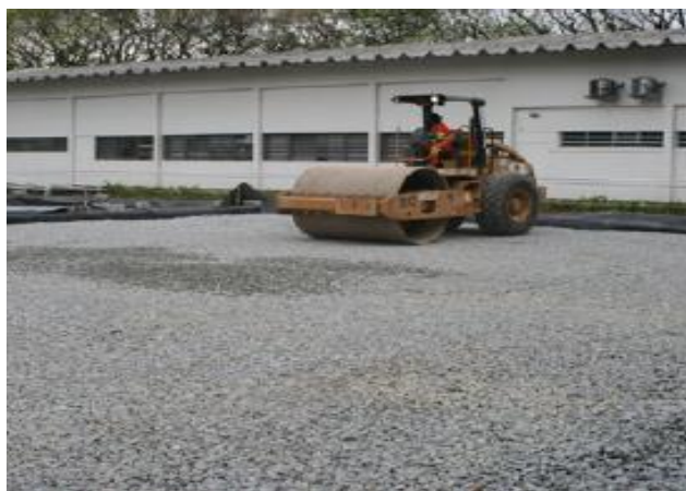
Figura 23: compactação das camadas de brita (Fonte: Acervo Afonso Virgiliis)
