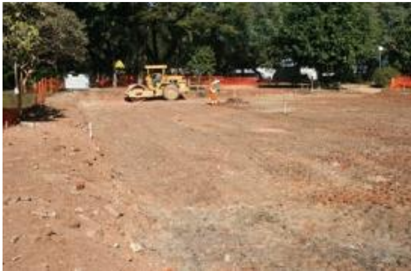
Figura 20: compactação do subleito (Fonte: Acervo Afonso Virgiliis)
