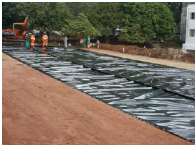
Figura 16: colocação da manta
