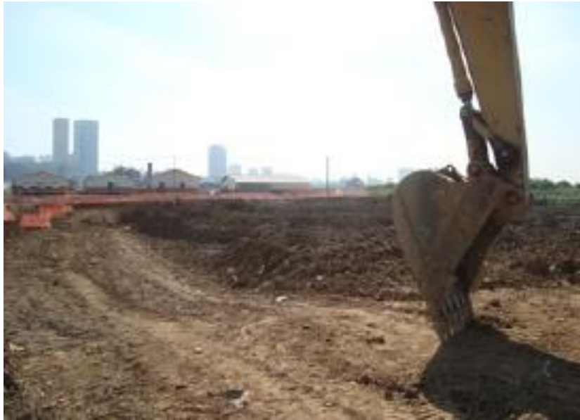
Figura 19: terraplanagem (Fonte: Acervo ABCP)
