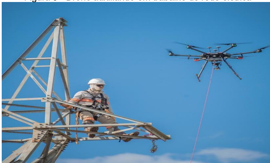
Figura 3 - Drone auxiliando em trabalho de rede elétrica
