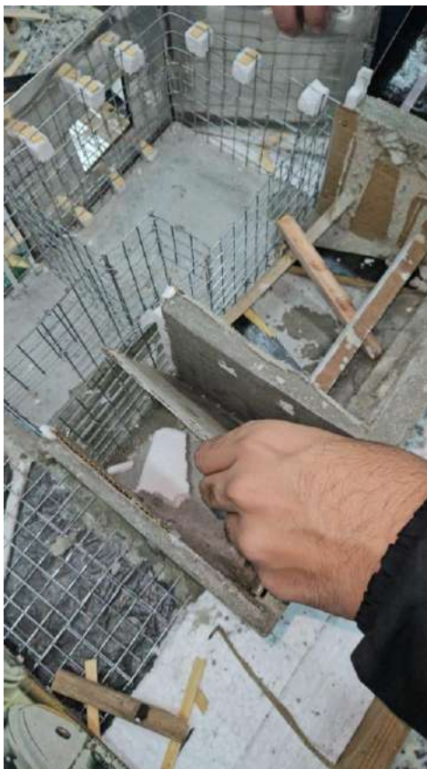
Imagem 11: Desforma das Paredes
