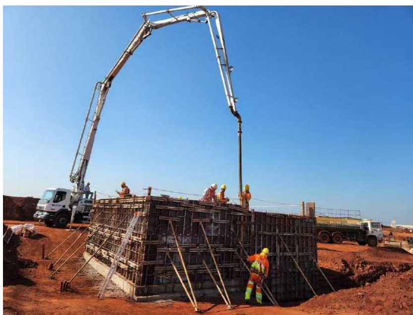
Imagem 7: Lançamento do concreto nas formas
