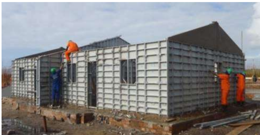
Imagem 2: Parede de concreto
