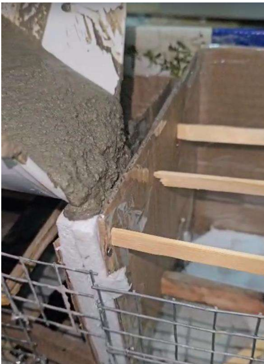
Imagem 10: Concretagem das Paredes
