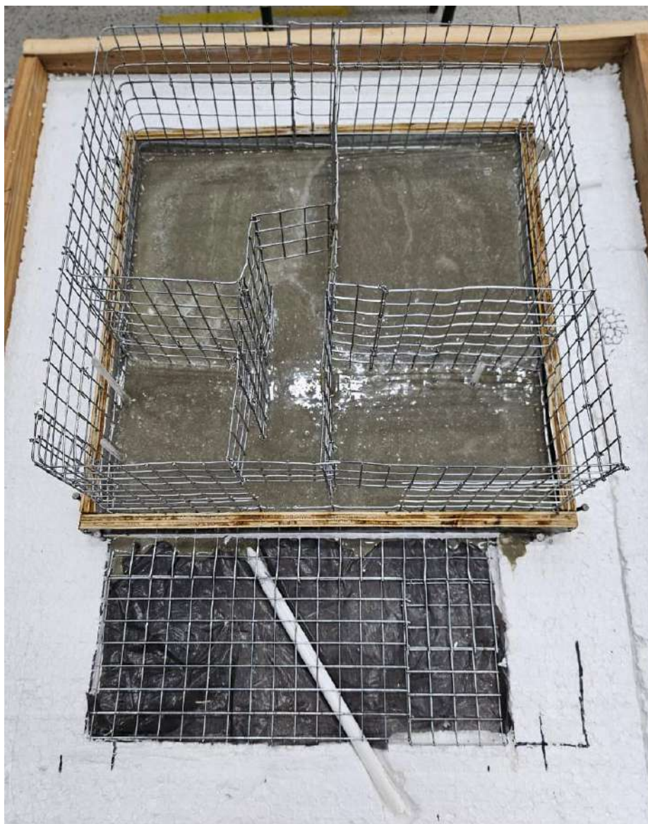
Imagem 9: Concretagem do radier
