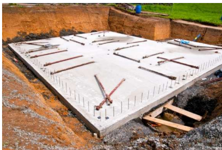
Imagem 4: Execução do Radier
