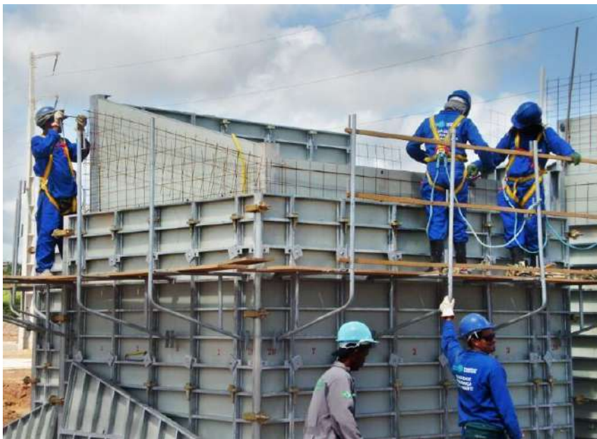
Imagem 5: Instalação das formas metálicas
