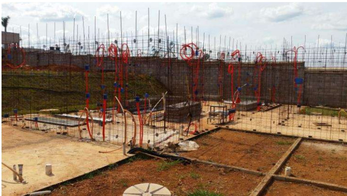
Imagem 6: Instalações elétricas embutidas nas armaduras
