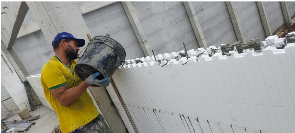
Figura 3 - Preenchimento das formas do Sistema ICF
