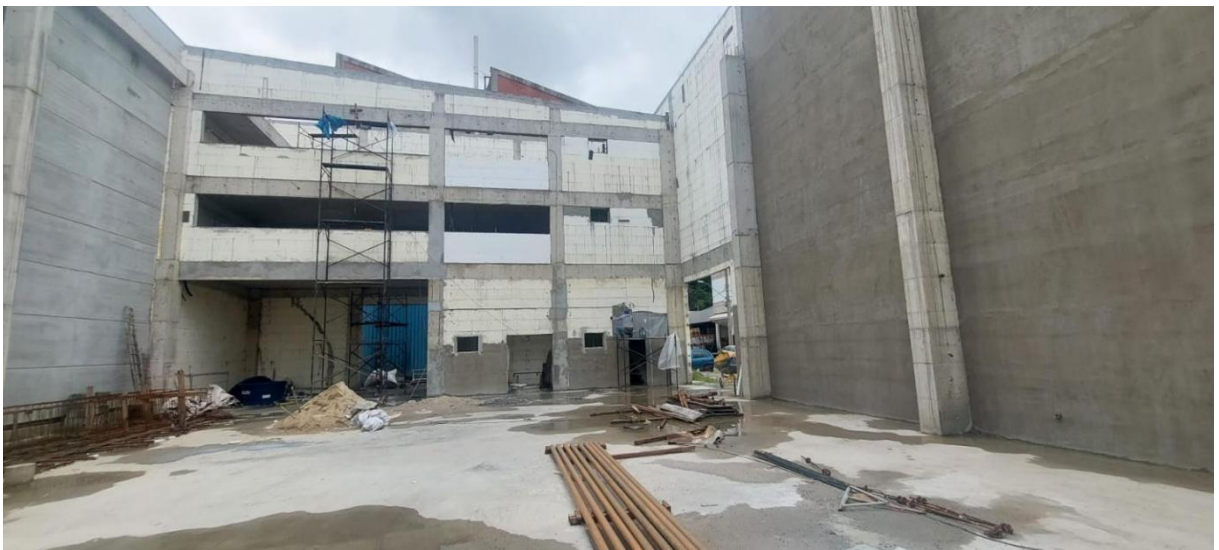
Figura 6 - Parede estrutural ICF
