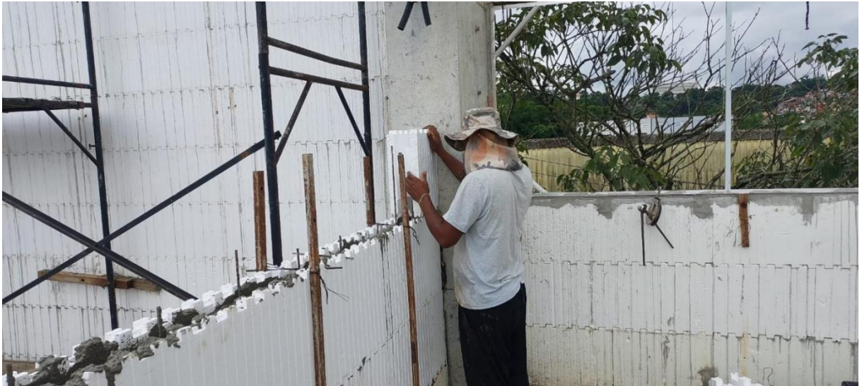
Figura 5 - Montagem do Sistema ICF
