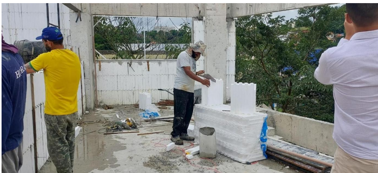
Figura 4 - Corte dos painéis do Sistema ICF
