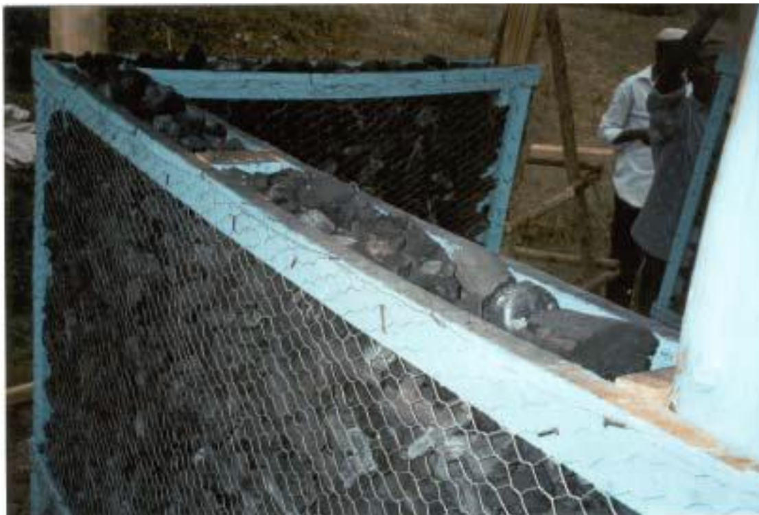
Figura 11 – Vista da parede de carvão vegetal e entrada
