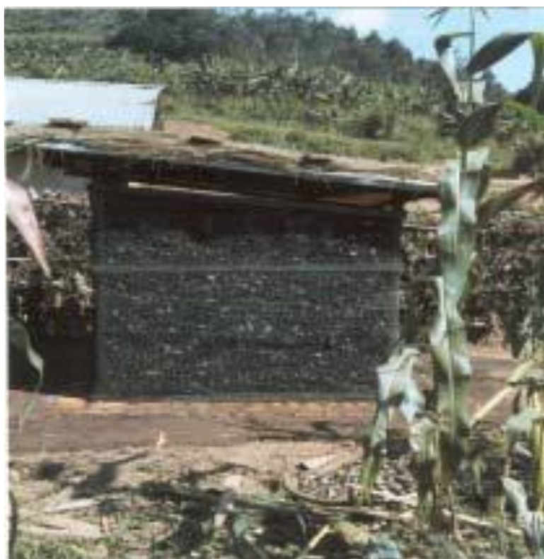
Figura 2 – Refrigerador evaporativo de carvão vegetal
