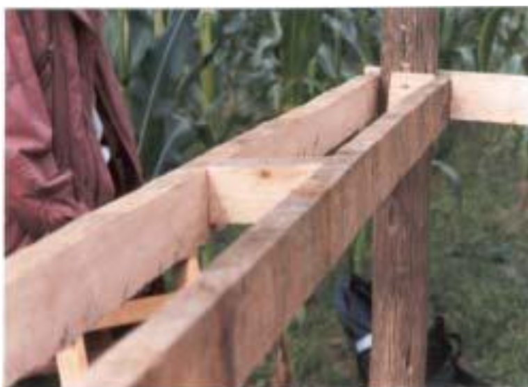
Figura 7 - Apoio de madeira para evitar deformação na parede
