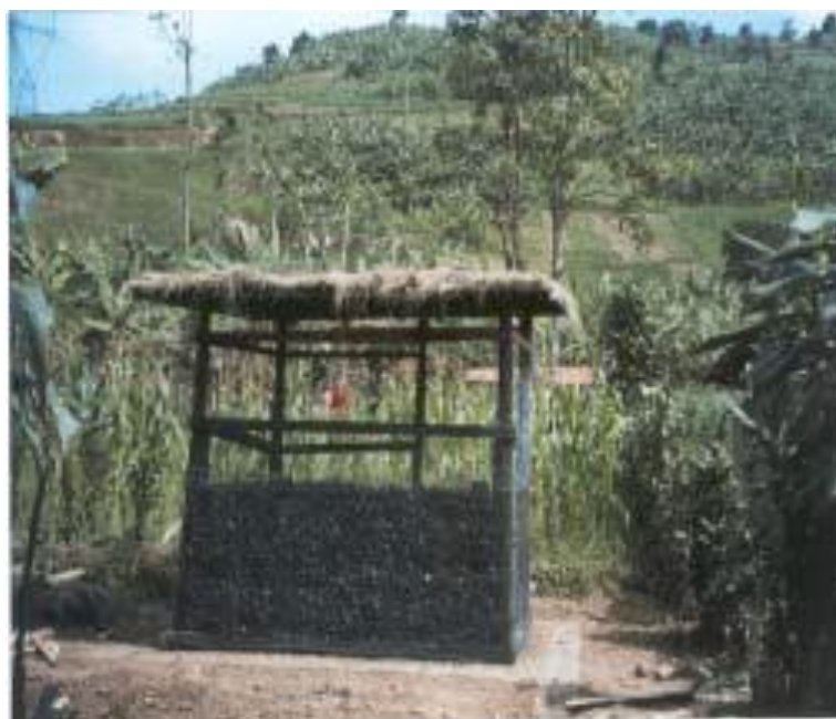
Figura 9 - Preenchendo paredes com carvão vegetal
