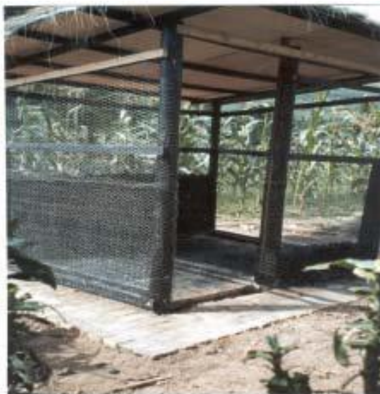
Figura 8 – Estrutura de madeira revestida com tela de arame
