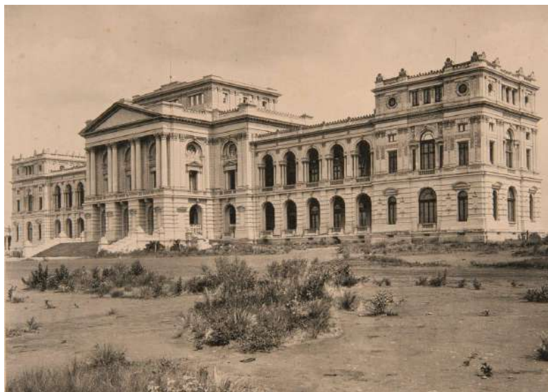
Foto 4: Guilherme Gaensly, "Edifício-Monumento, fachada e lado direito", 1890. Fotografia. Acervo Museu Paulista, Universidade de São Paulo. Domínio público.
