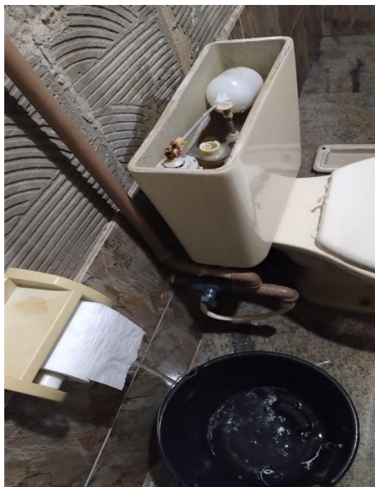
Figura 5 – Recepção da tubulação ao vaso sanitário
