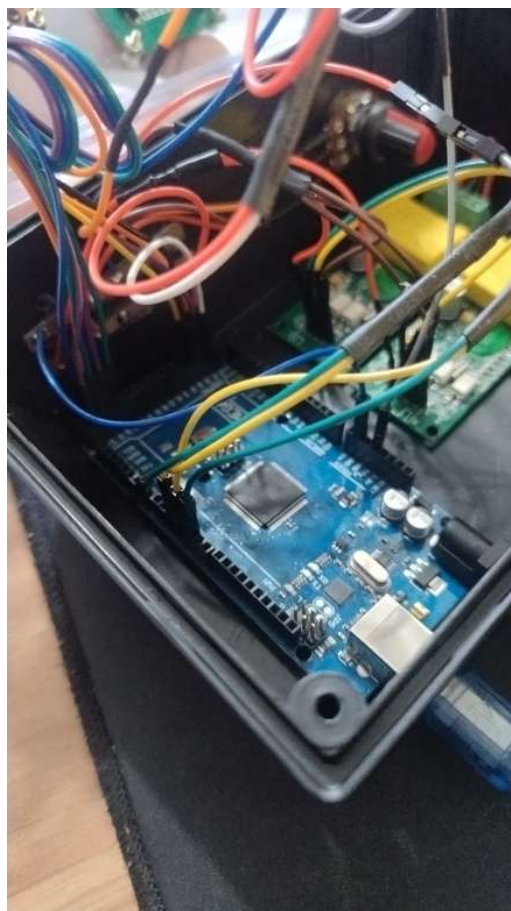
Figura 43 - Resultado final da organização interna dos cabos e componentes II
