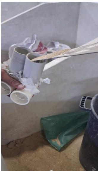
Figura 12-Areia sendo colocada nos canos de filtragem
