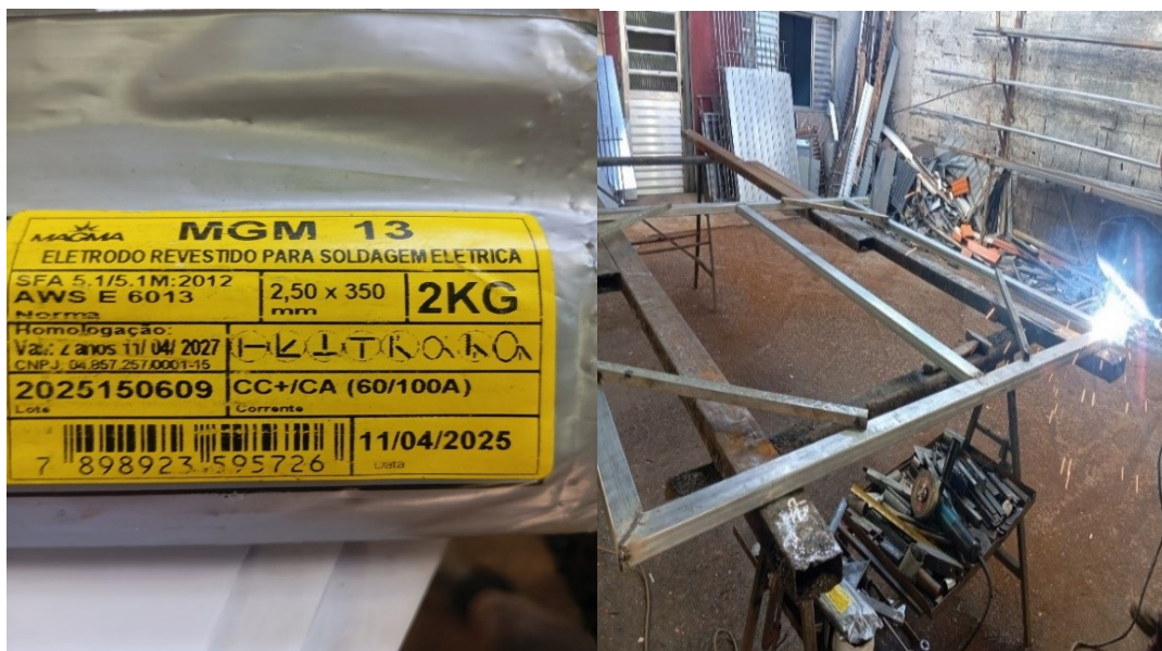
Figura 11 – Início da construção da bancada
