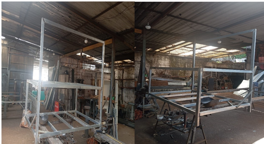
Figura 13 – Montagem parcial da estrutura.
