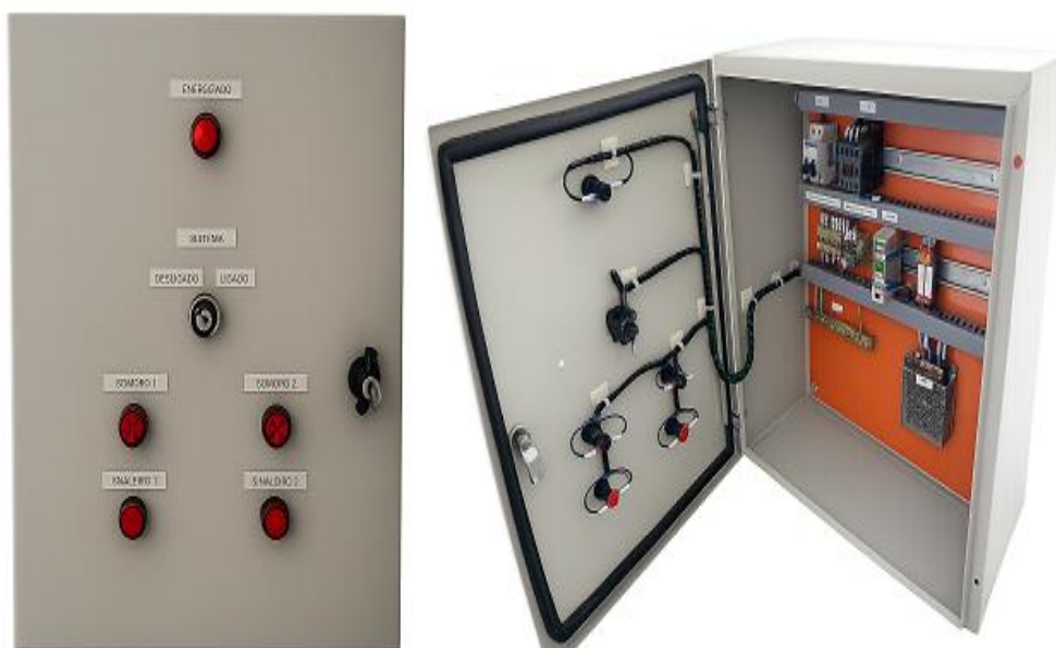
Figura 19: Painel elétrico montagem finalizado
