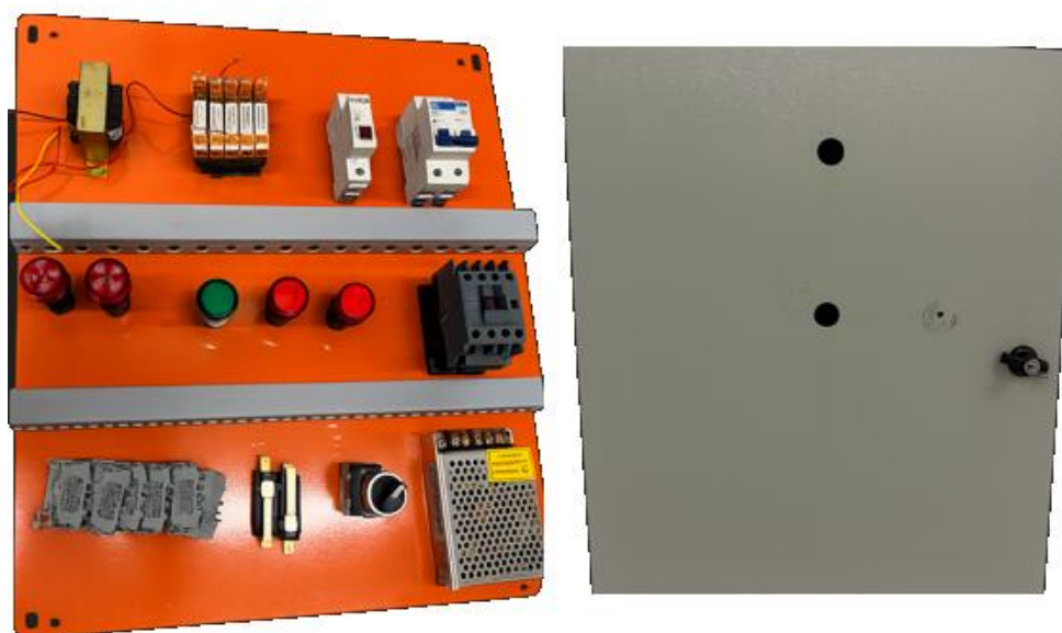
Figura 16: Iniciando a montagem do painel elétrico
