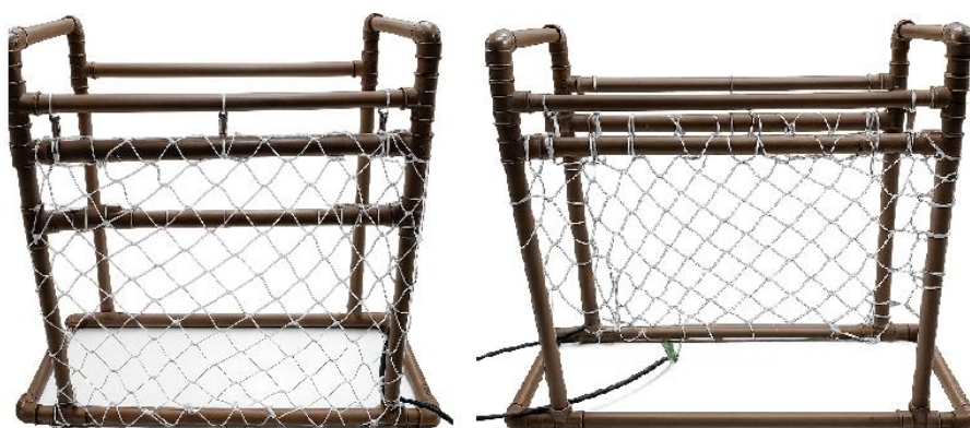
Figura 15: Estrutura da tela de proteção finalizada
