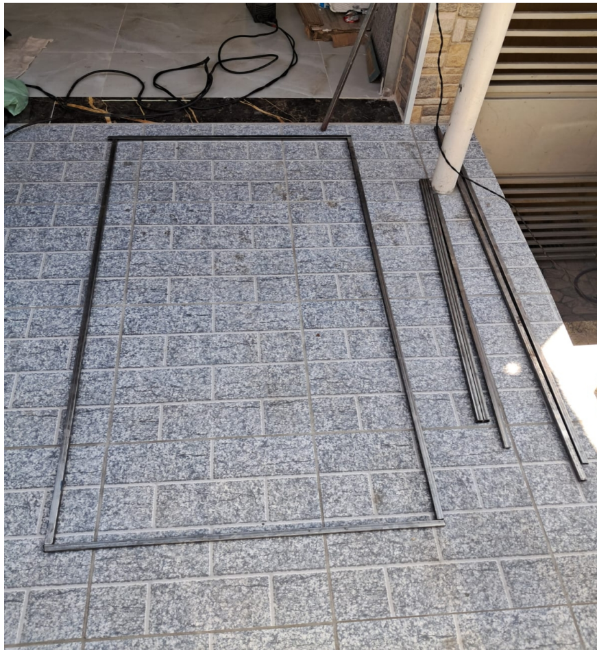
Figura 6 – Montagem gradual da estrutura
