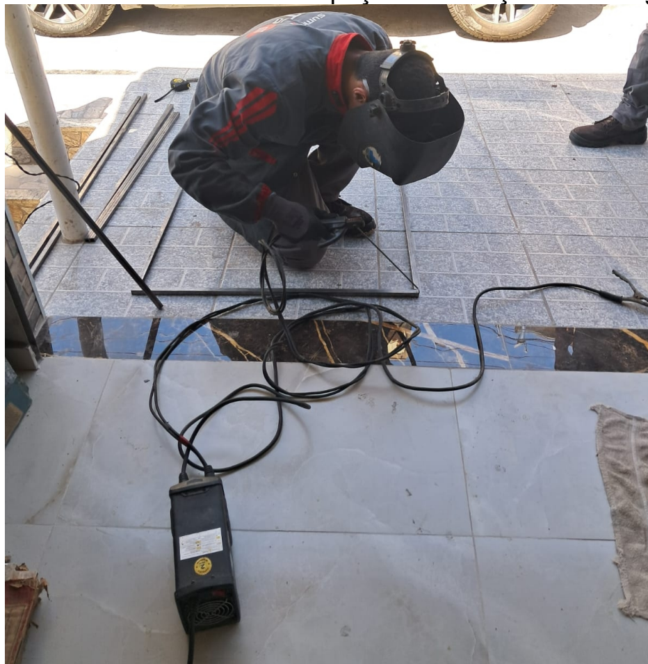
Figura 5 – Posicionamento das peças e execução da soldagem
