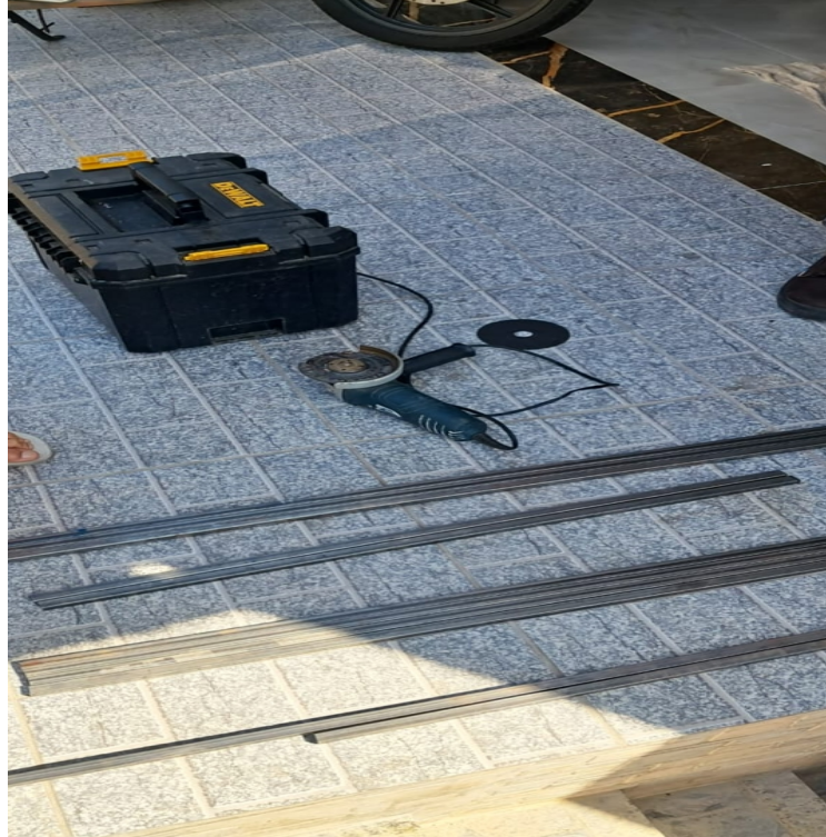
Figura 4 – Corte e preparação dos perfis metálicos
