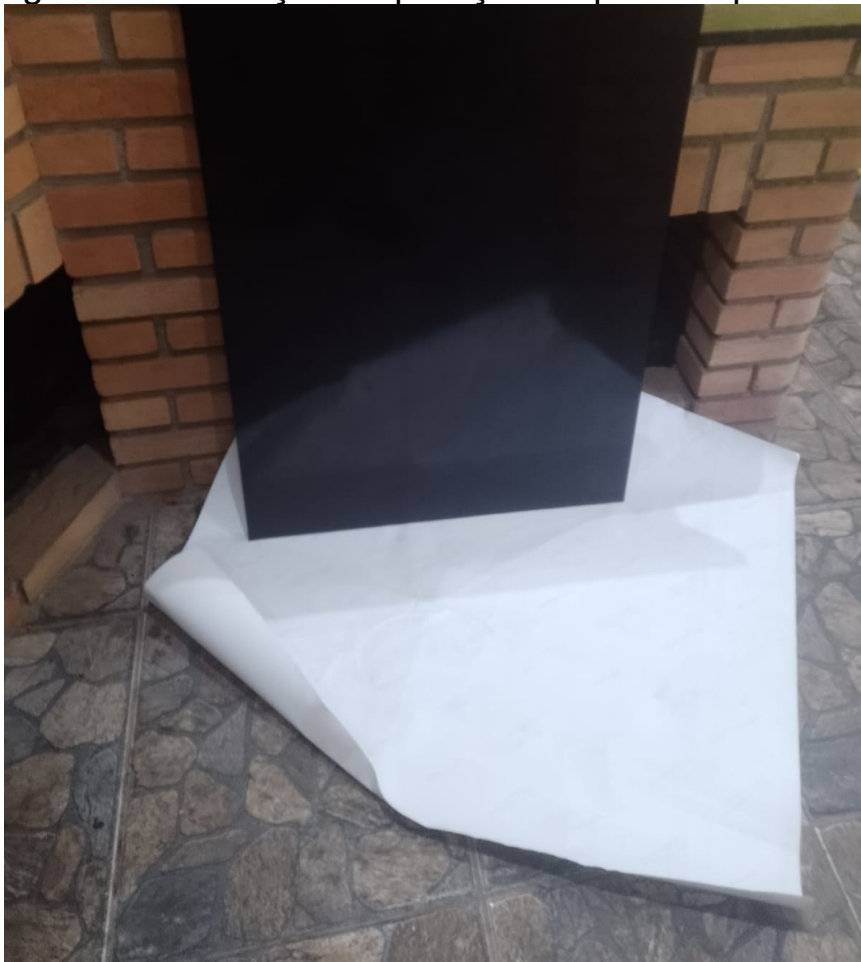
Figura 9 - Instalação e aplicação de película protetora
