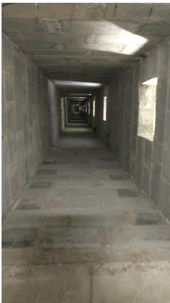
Figura 16 - Vista interna do Shaft
