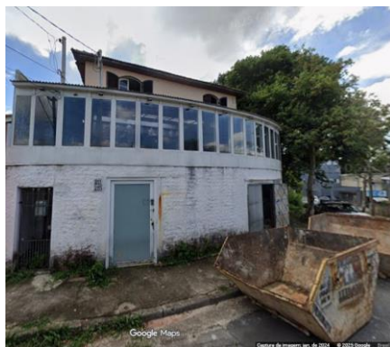
Imagem 1 - Captura de imagem da fachada da residência localizada na Rua Abadia dos Dourados, nº 211, Vila Indiana – São Paulo (05586-030)
