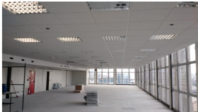
Imagem 2 – Reforma comercial de escritórios
