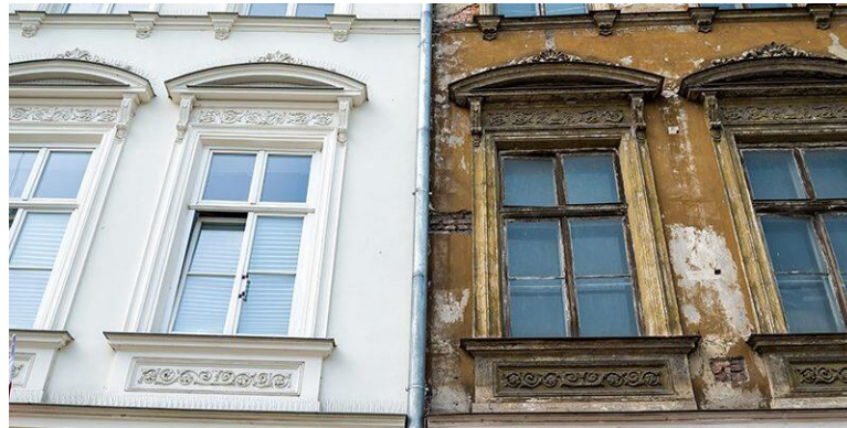
Imagem 4 – Reforma retrofit de um edifício deteriorado
