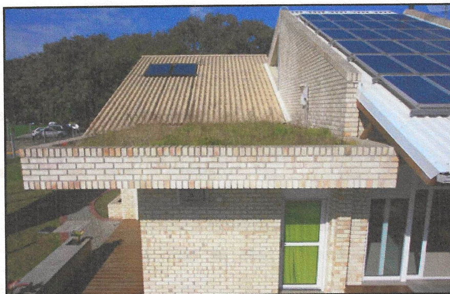
Figura 19: telhado verde e aquecedor solar
