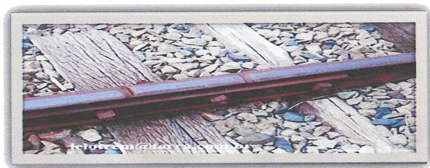
Figura 7: Tala Fazendo ligação entre 3 peças de trilho
