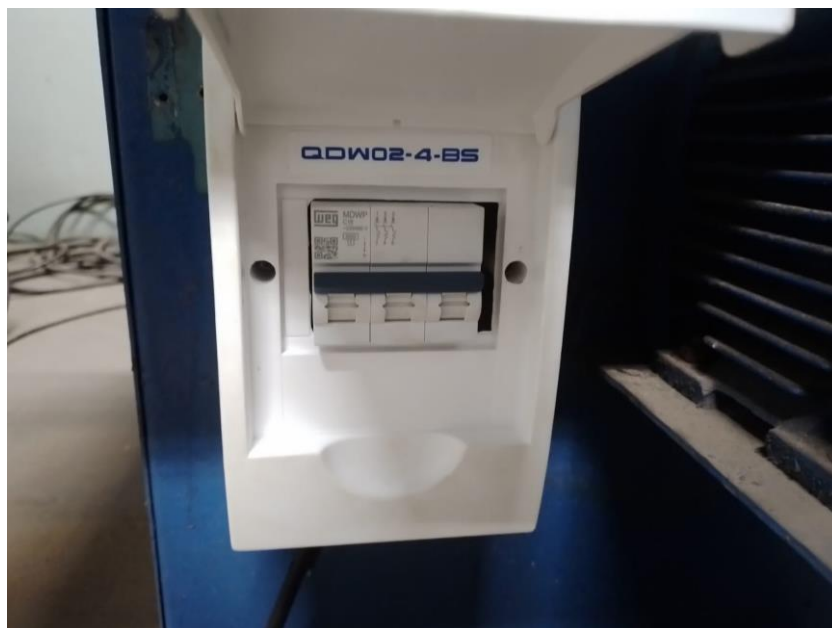
Figura 8 - Disjuntor termomagnético e caixa de montagem
