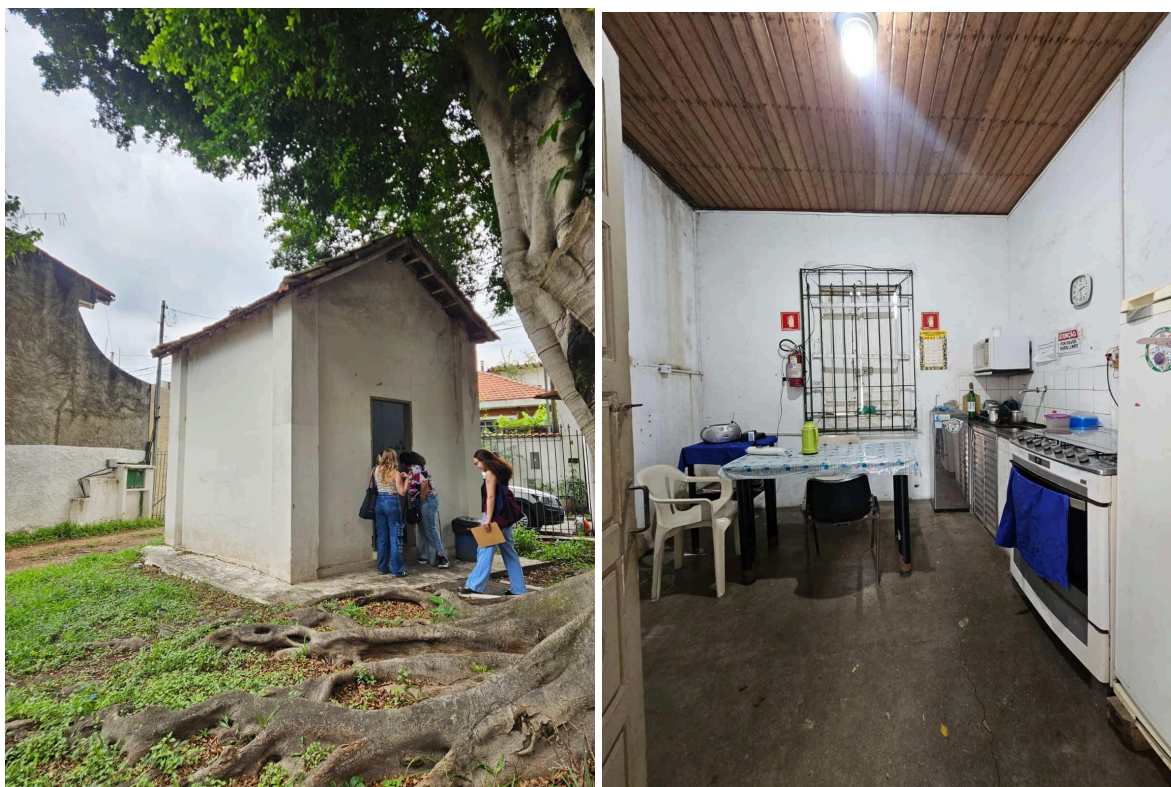
Imagem 26 - Espaço exterior da copa
