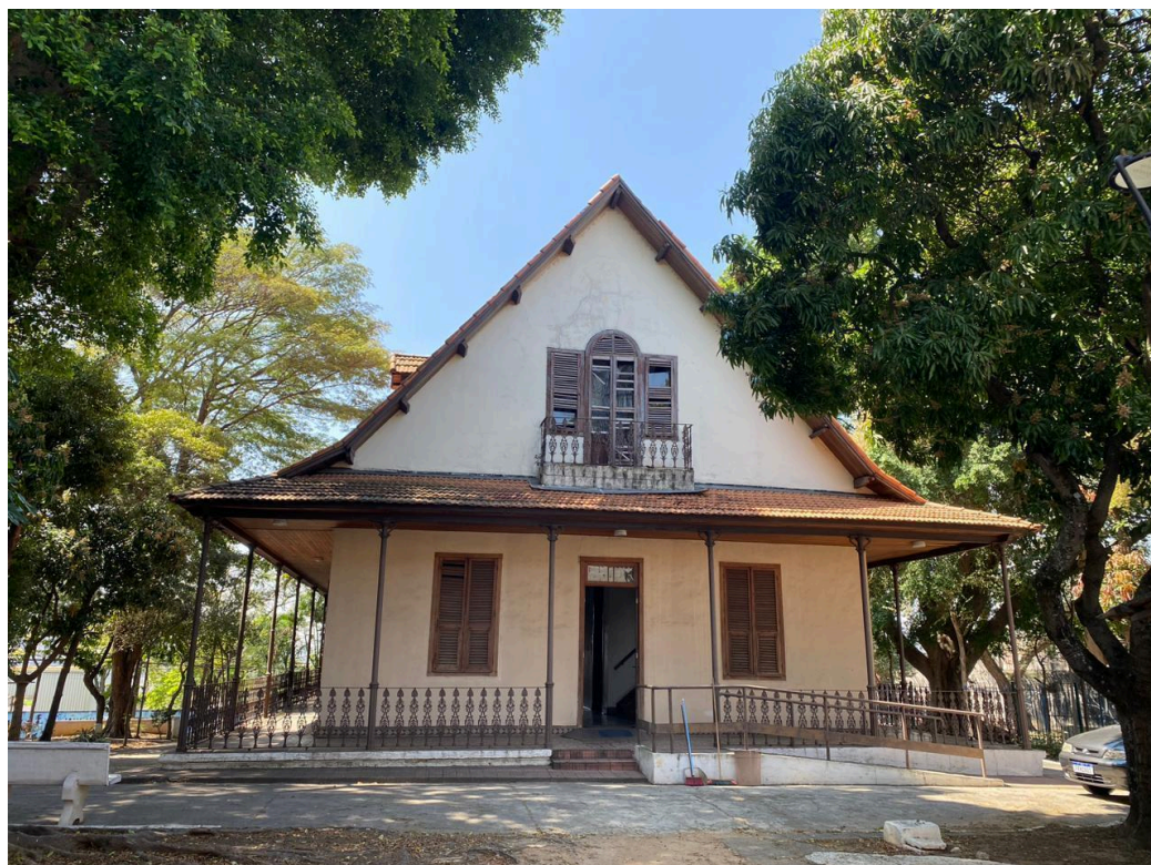
Imagem 19 - Acesso secundário, acessível por rampa e plataforma
