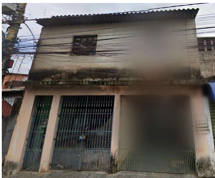
Figura 8 – Fachada Frontal da edificação, evidenciando o objeto de estudo.
