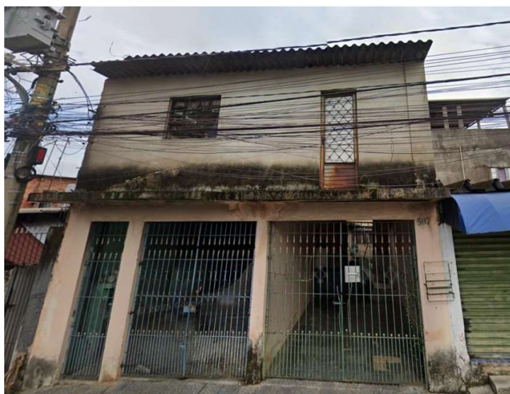
Figura 6 – Fachada do imóvel atualmente.
