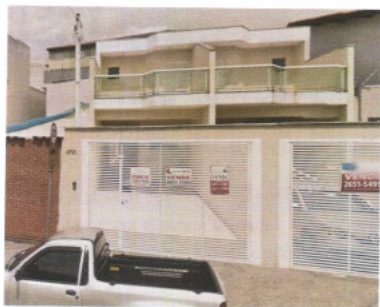
Figura 18: Fachada da edificação
