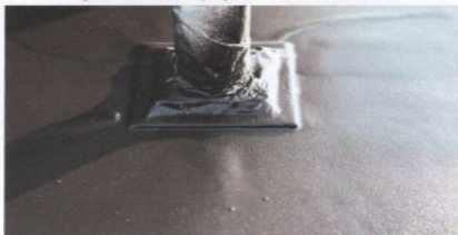
Figura 44 - Acabamento de Aplicação com Geotextil - www.versaflex.com
