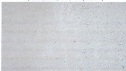
Figura 27 - Superfície Preparada - Apostila Polyurea University
