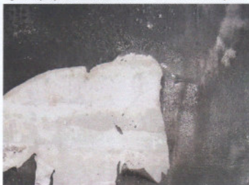
Figura 19 - Aplicação sem tratamento das "bicheiras" - White Book "Surface Preparation"
