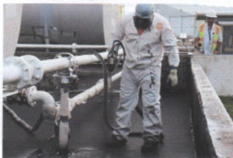
Figura 43 - Acabamento de Aplicação sobre Geotextil em Bacia de Contenção - www.versaflex.com
