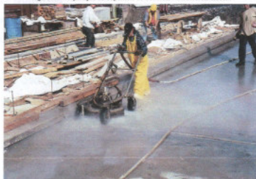
Figura 49 - Preparação de Superfície de Concreto - www.versaflex.com
