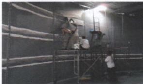
Figura 33 - Tratamento sobre a área dos parafusos - www.versaflex.com
