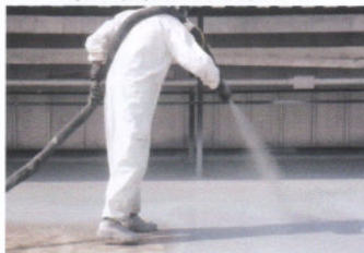
Figura 51 - Aplicação sobre Concreto - Arquivo Pessoal
