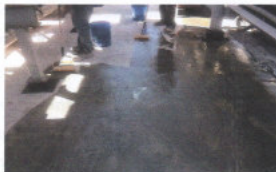
Figura 50 - Aplicação de Primer em Concreto - www.versaflex.com
