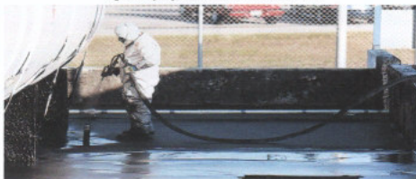
Figura 45 - Aplicação sobre Geotextil - www.versaflex.com
