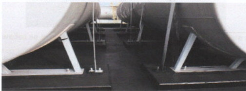
Figura 41 - Acabamento de Aplicação de Geotextil em Bacia de Contenção - www.versaflex.com
