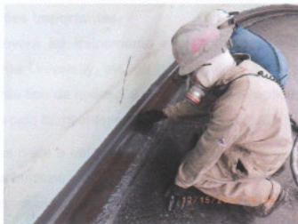
Figura 35 - Preparação do Rodapé de Tanque - www.versaflex.com
