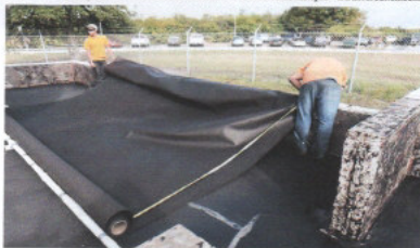
Figura 38 - Aplicação de Poliureia sobre Geotextil em Bacia de Contenção - www.versaflex.com
