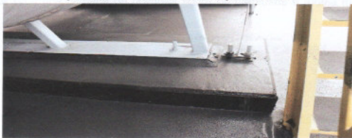
Figura 41 - Acabamento de Aplicação de Geotextil em Bacia de Contenção - www.versaflex.com
