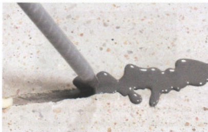
Figura 48 - Aplicação de Selante de Poliureia em Junta de Dilatação - www.versaflex.com
