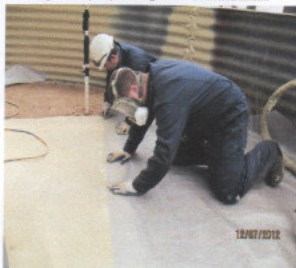
Figura 38 - Aplicação de Poliureia sobre Geotextil em Bacia de Contenção - www.versaflex.com
