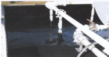
Figura 43 - Acabamento de Aplicação sobre Geotextil em Bacia de Contenção - www.versaflex.com
