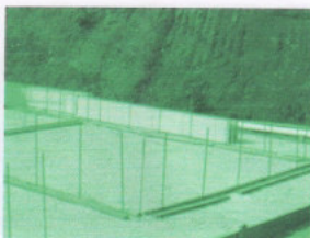
Figura 1: Linha de Montagem execução do radier
