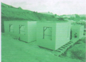
Figura 3: Linha de Montagem Escoramento e Concretagem
