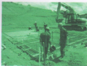
Figura 1: Linha de Montagem execução do radier
