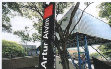
Figura 9 – Estação de Metrô Artur Alvim.
