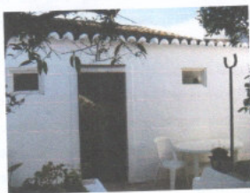
Foto 8: Paredo porosa pintada com tinta à base de cal (Fonte: Caiarte)
