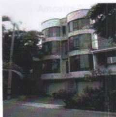
Fachada do prédio
