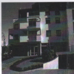
Fachada do prédio
