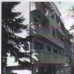
Fachada do prédio
