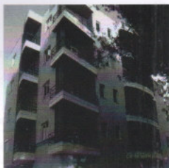
Fachada do prédio
