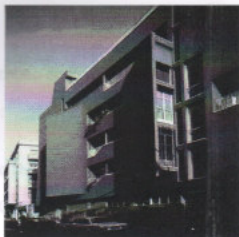
Fachada do prédio
