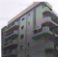
Fachada do prédio
