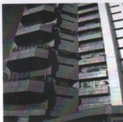
Fachada do prédio
