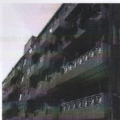
Fachada do prédio
