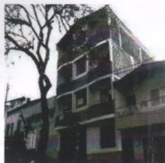
Fachada do prédio
