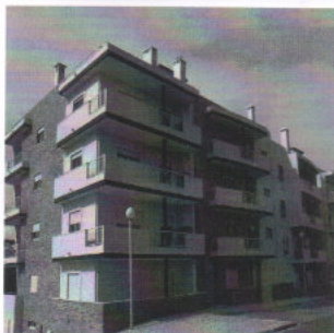
Fachada do prédio
