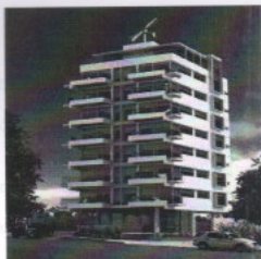
Fachada do prédio
