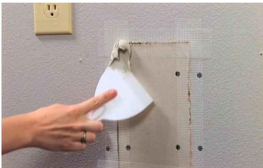
Figura 13 - Reparos no Drywall.
