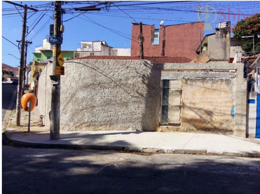
Figura 20: Vista da frente do terreno.
