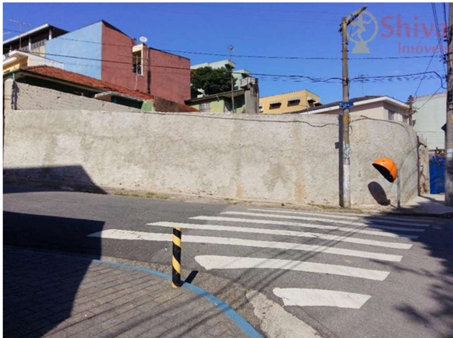
Figura 19: Vista lateral do terreno.
