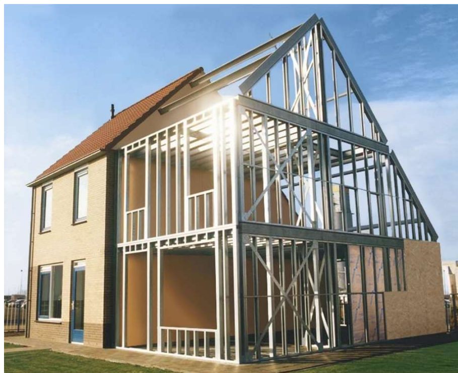
Figura 1: Sulmodulos treinamento de Steel Frame.
