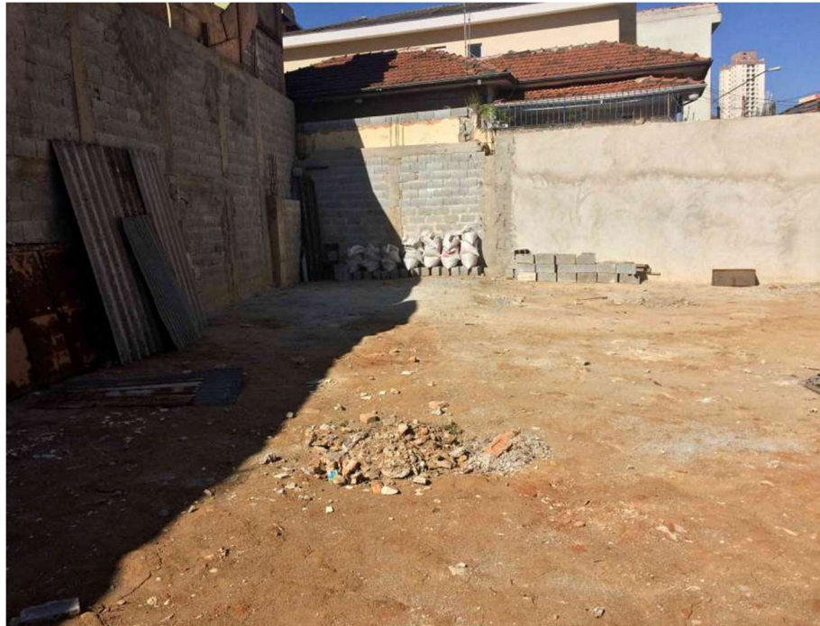
Figura 16: Vista do local do terreno.
