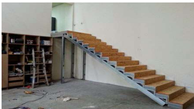
Figura 10: Escada Light Steel Frame.
