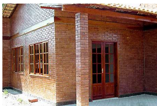
Imagem 9: Parede externa e interna (tijolo de solo cimento)
